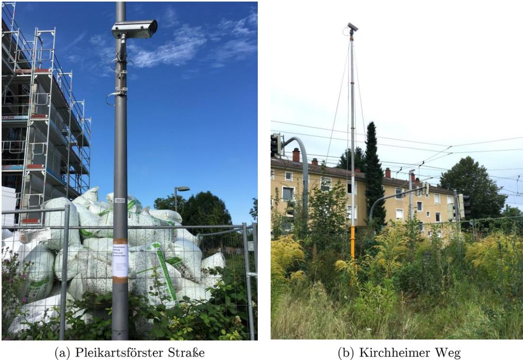
Abbildung 10: Montage der Camcorder für die Verkehrsbeobachtungen an Straßen mit breiten Schutzstreifen
