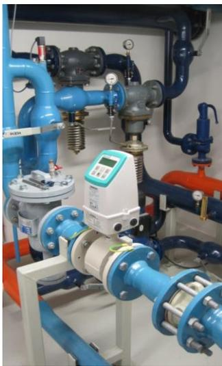
**Abbildung 4:** Warmwasserbeschickung eines Wohnhauses mit Anschluss an das Straßenheizungssystem
