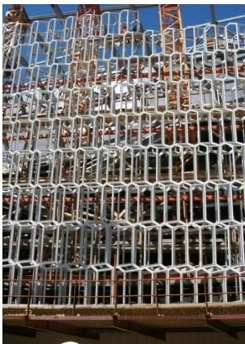
**Abbildung 11:** Montage der Fassadenelemente
