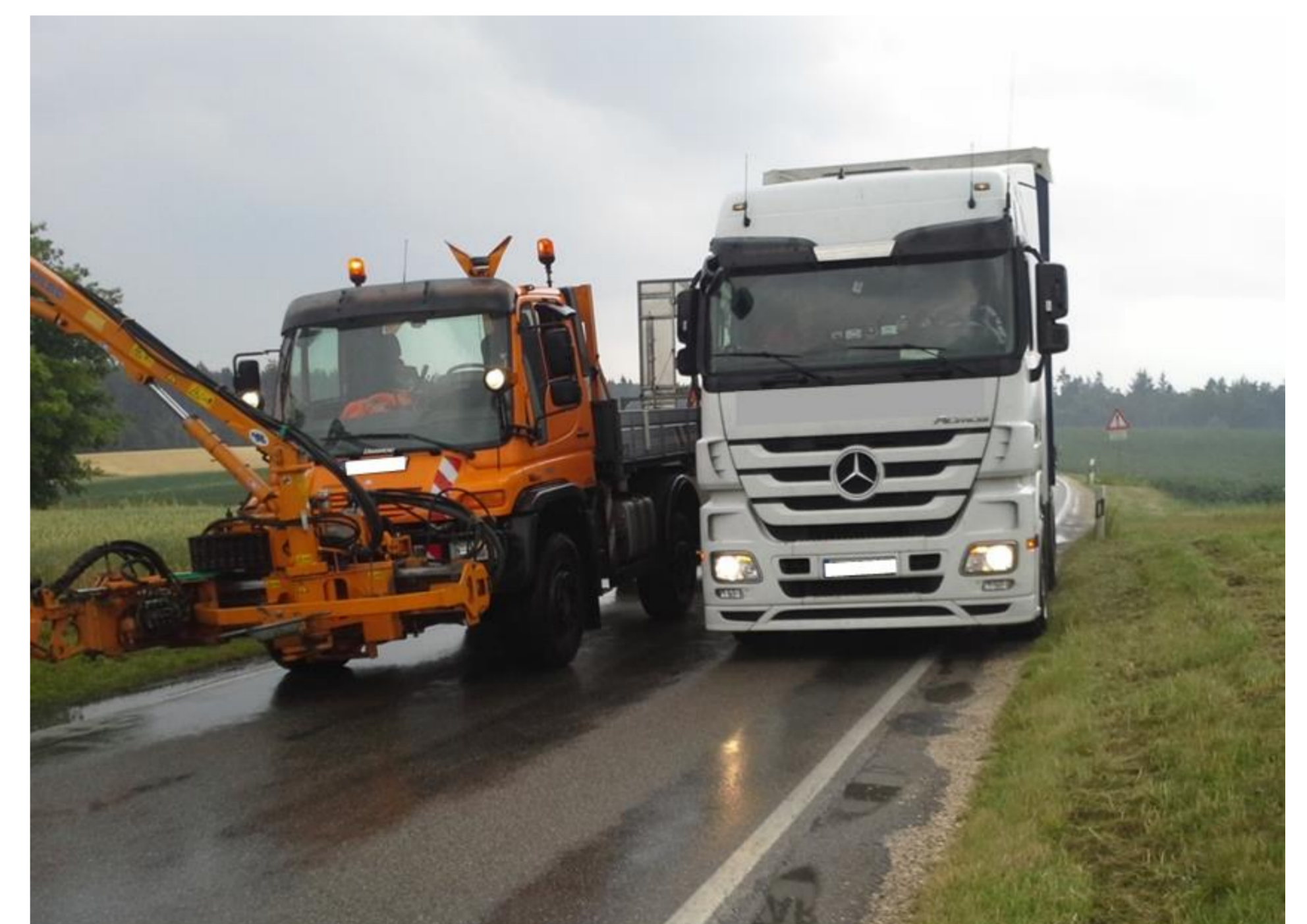
Fahrzeuge müssen teilweise über das Bankett ausweichen, Quelle: Bayerische Straßenbauverwaltung
