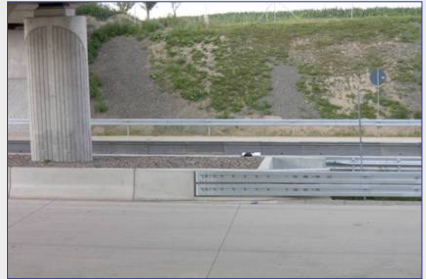
Anordnung von Schutzplanken bei Brücken- pfeilern von Überführungsbauwerken im Mittelstreifen (BAB A 17, 2004)
