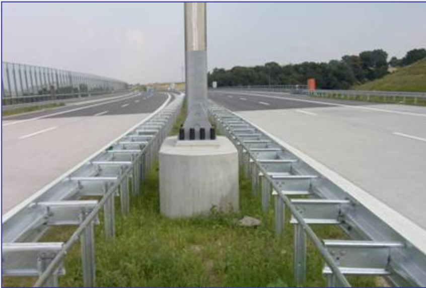
Anordnung von Schutzplanken bei Stützen von Schilderbrücken im Mittelstreifen (BAB A 17, 2005)
