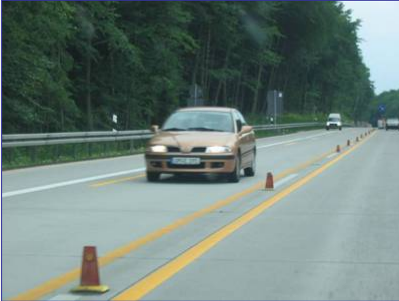
3+0 Verkehrsführung in Arbeitsstellen Richtungstrennung mit „Bischofsmützen“ (BAB A 11, 2005)
