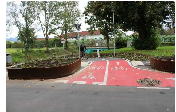
Optimierung von Rad- und Fußverkehrsführung an einer Bahnunterführung (Bild: Stadt Emmendingen)
