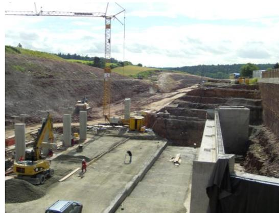
Herstellung einer Bohrpfehlwand zur Böschungssicherung im Einschnitt (links), Bau einer Kreisstraßenüberführung bei Mutschelbach (rechts)
