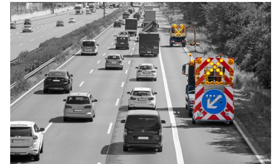
Absicherung eines Arbeitsfahrzeuges bei Mäharbeiten (Bildquelle: Hessen Mobil)
