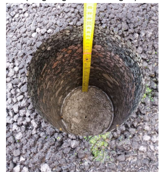
Bohrloch nach Bohrkernentnahme (Materialeigenschaften)
