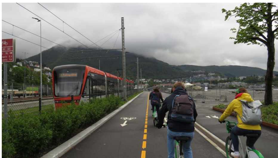
Abbildung 12: Radweg neben der Stadtbahntrasse
