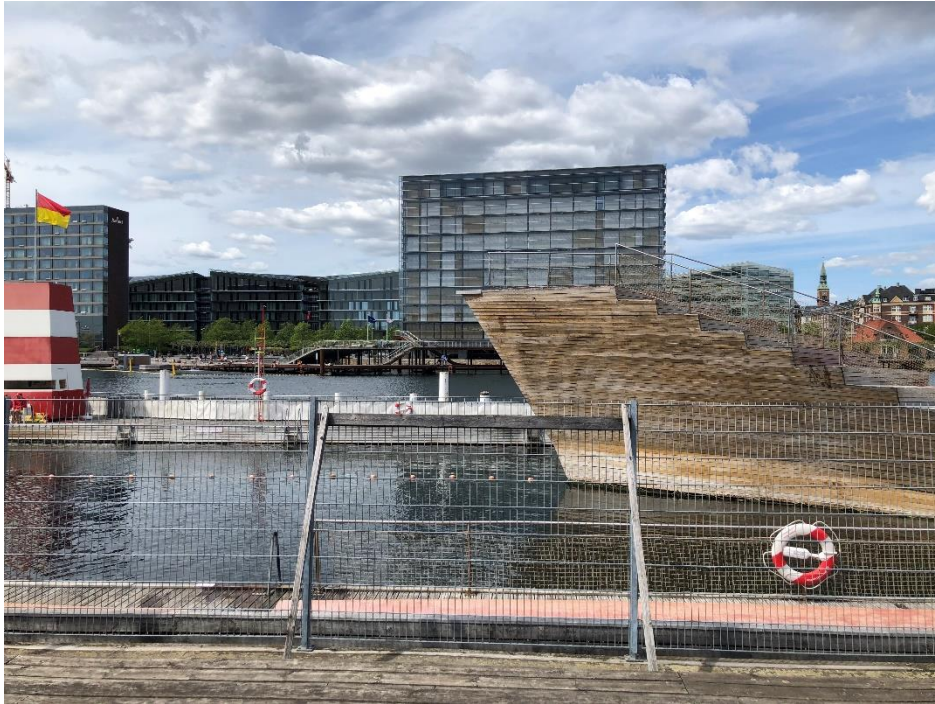
Abbildung 29: Hafengebäude in Islands Brygge
