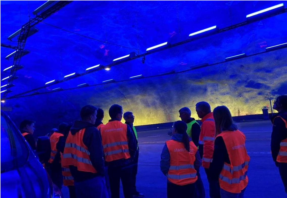
Abbildung 18: Aufweitung des Lærdalstunnels mit innovativem Lichtkonzept
