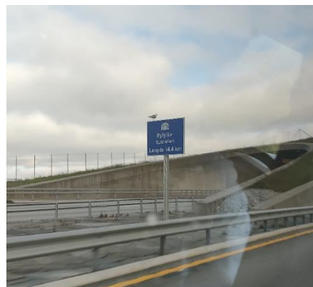
Abbildung 2: Einfahrt zum Ryfast-Tunnel
