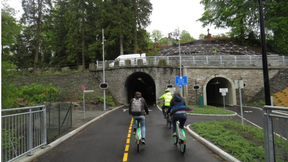
Abbildung 13: Radweg neben der Stadtbahntrasse
