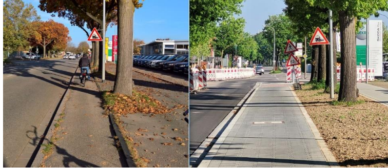
Tullastr. - BA 1: Sanierung / Umbau - Schrägbordsteine
