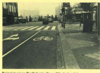
Beispiel eines Radfahrstreifens (Niederlande)
