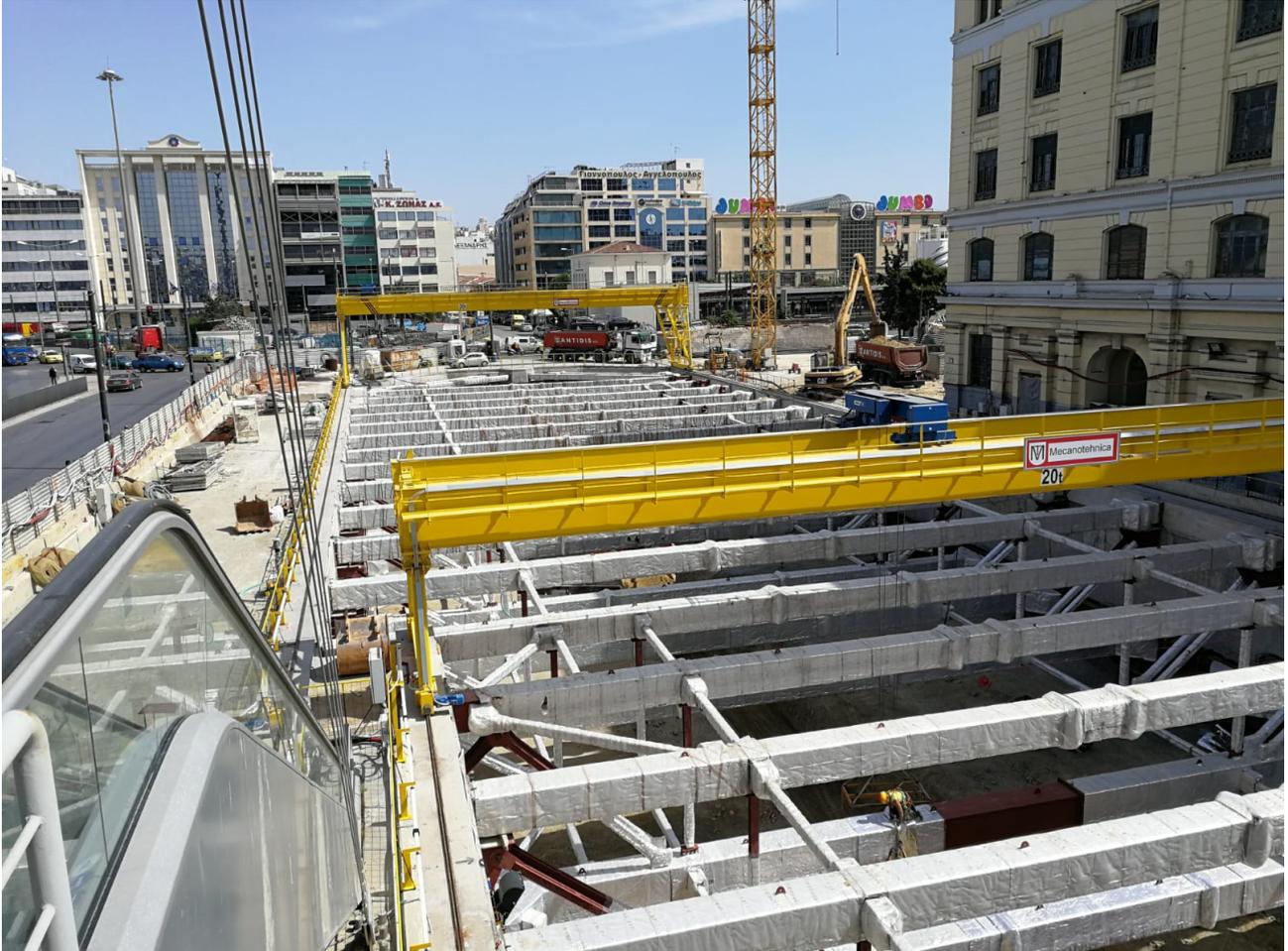
Abbildung 7: Baustelle der Metro-Station; gut erkennbar die aufwändig ummantelte Querverstrebung
