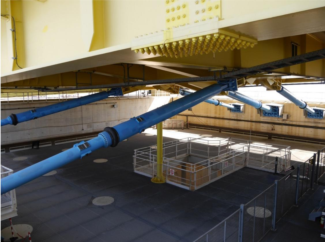
Abbildung 26: Das Dämpfersystem im Inneren eines Pfeilers der Rio-Antirrio-Brücke
