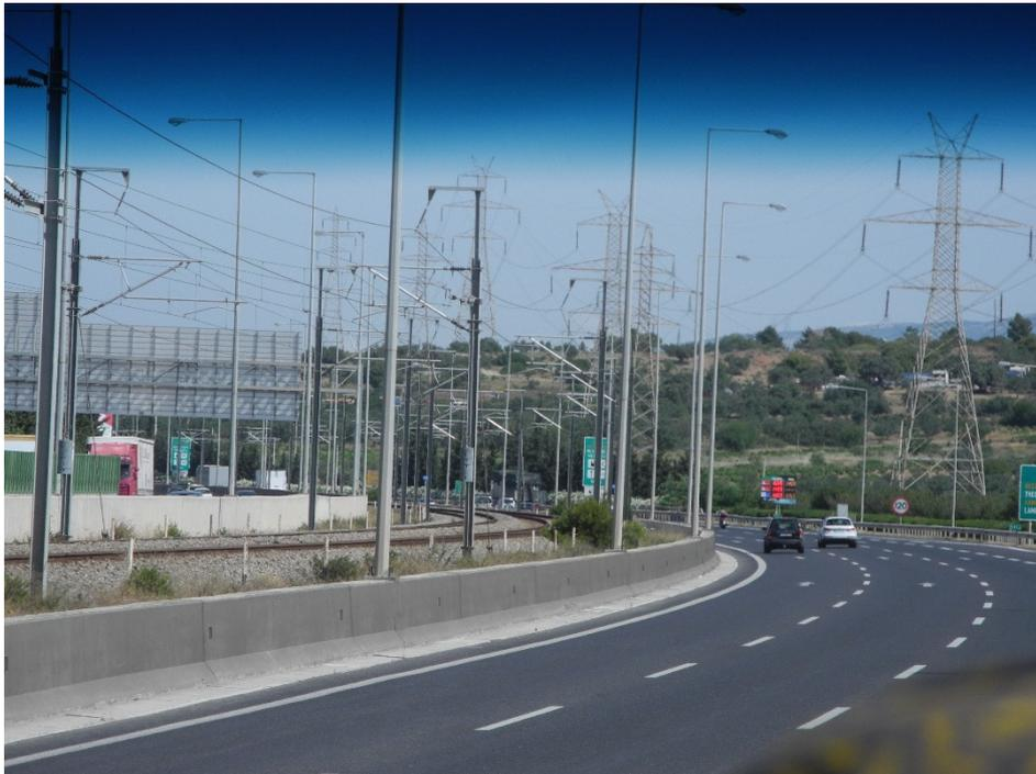
Abbildung 2: Attiki Odos mit Nahverkehrs-Bahnstrecke zwischen den Richtungsfahrbahnen
