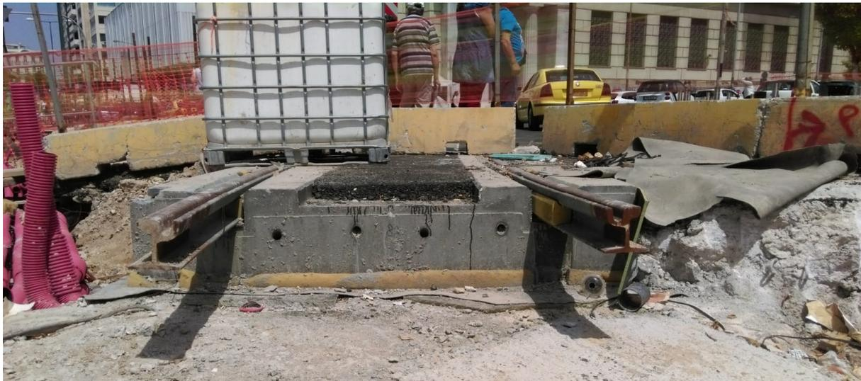
Abbildung 4: Oberbauform Embedded Rail System
