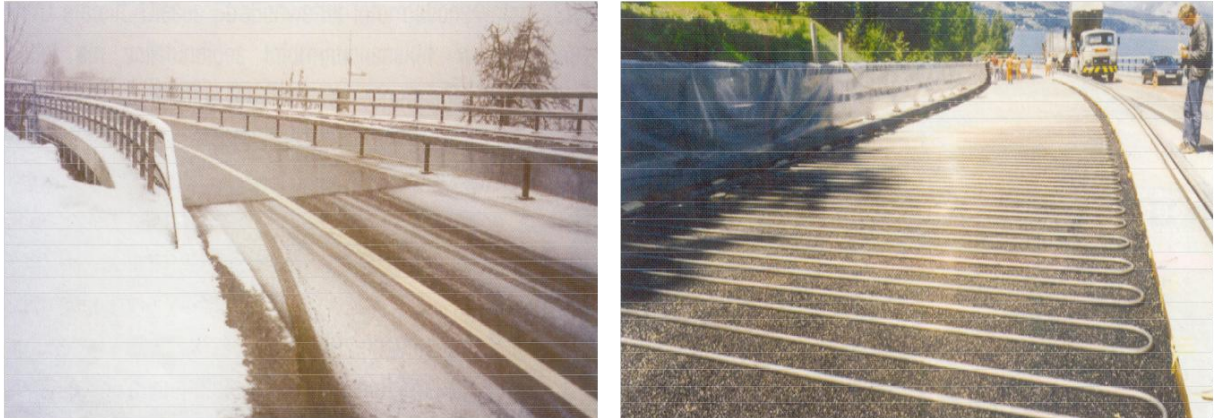
Bild 2.33: Heizspiralen in der Fahrbahn (DURTH/HANKE, 2004)
