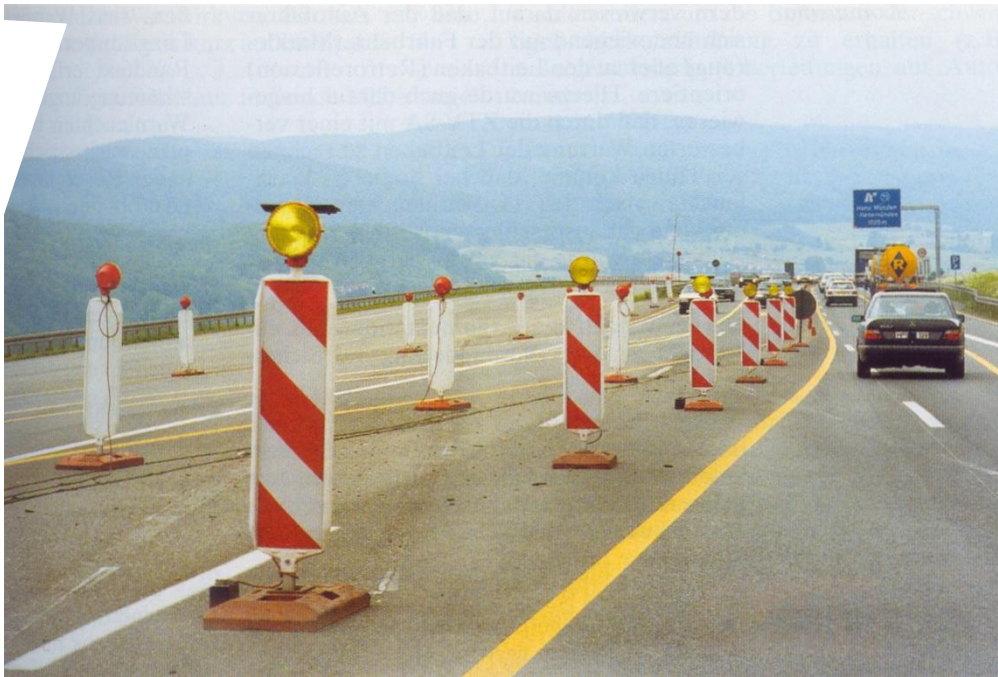
Bild 6.5: Leiteinrichtungen an einer Arbeitsstelle
