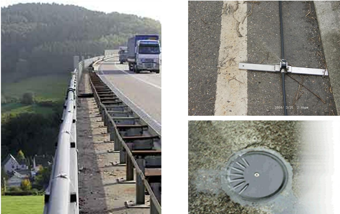
Bild 2.31: Taumittelsprühanlage (stationär)
