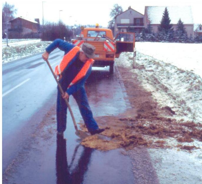
Bild 4.1: Reinigen der Fahrbahn
