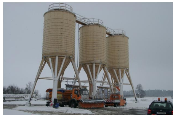
Bild 2.4: Salzlagerung in Silos
