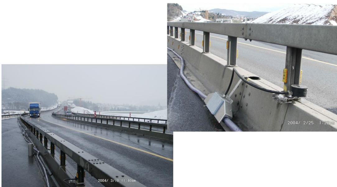
Bild 2.32: Taumittelsprühanlage (mobil)
