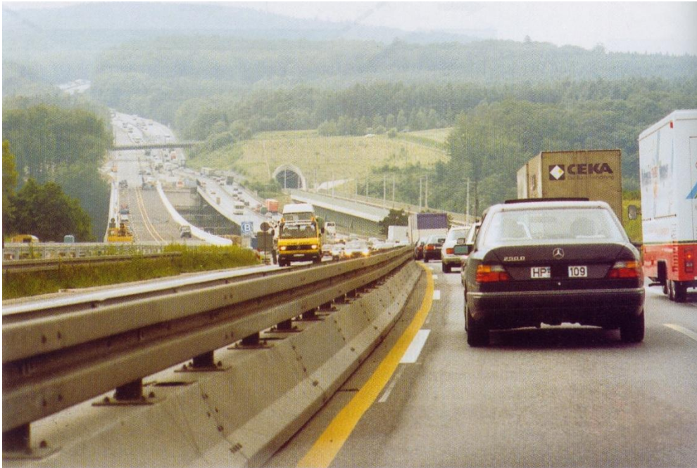
Bild 6.9: Leitwand an einer AID mit 4+0 Verkehrsführung
