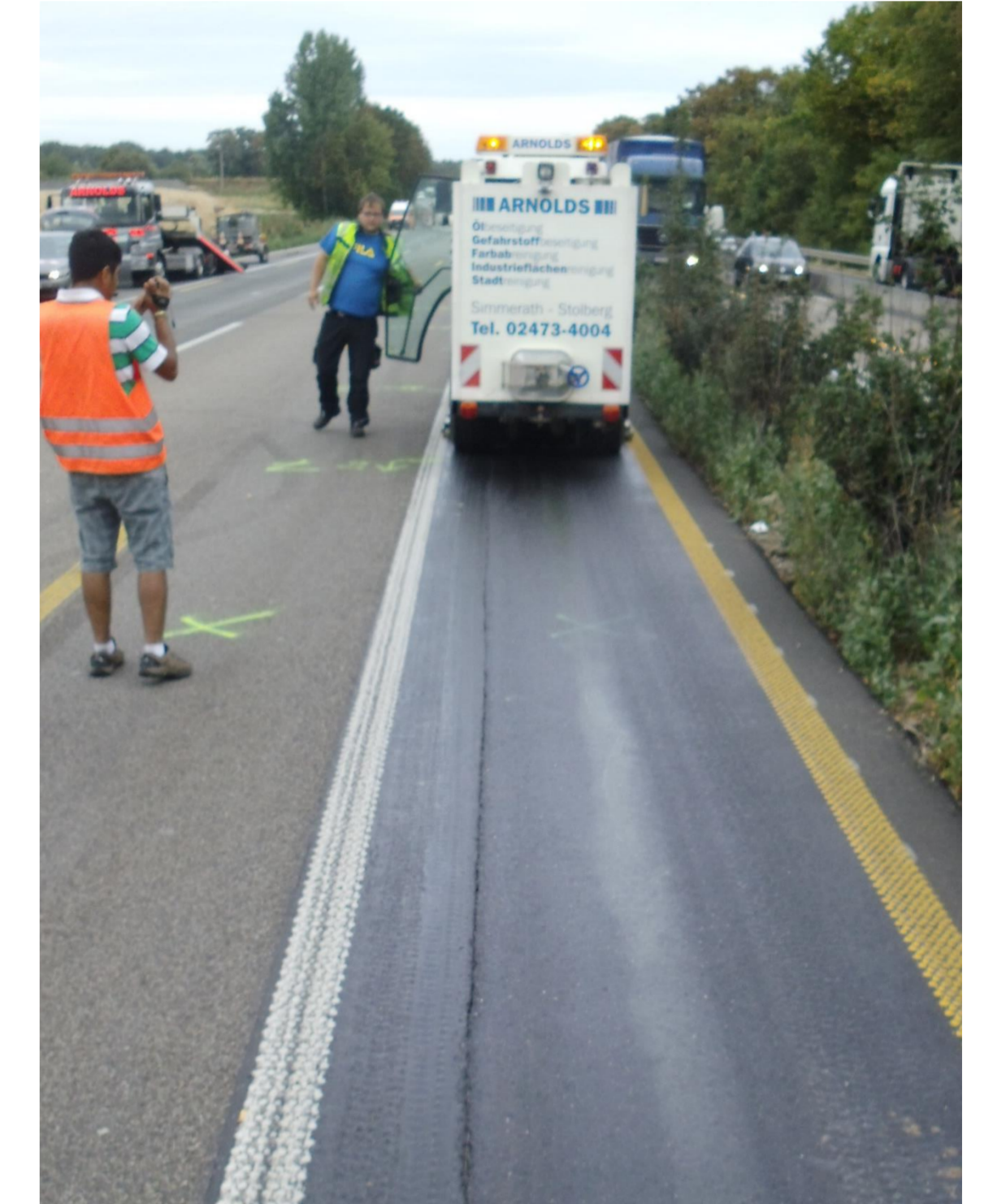
Einsatz einer Nassreinigungsmaschine
