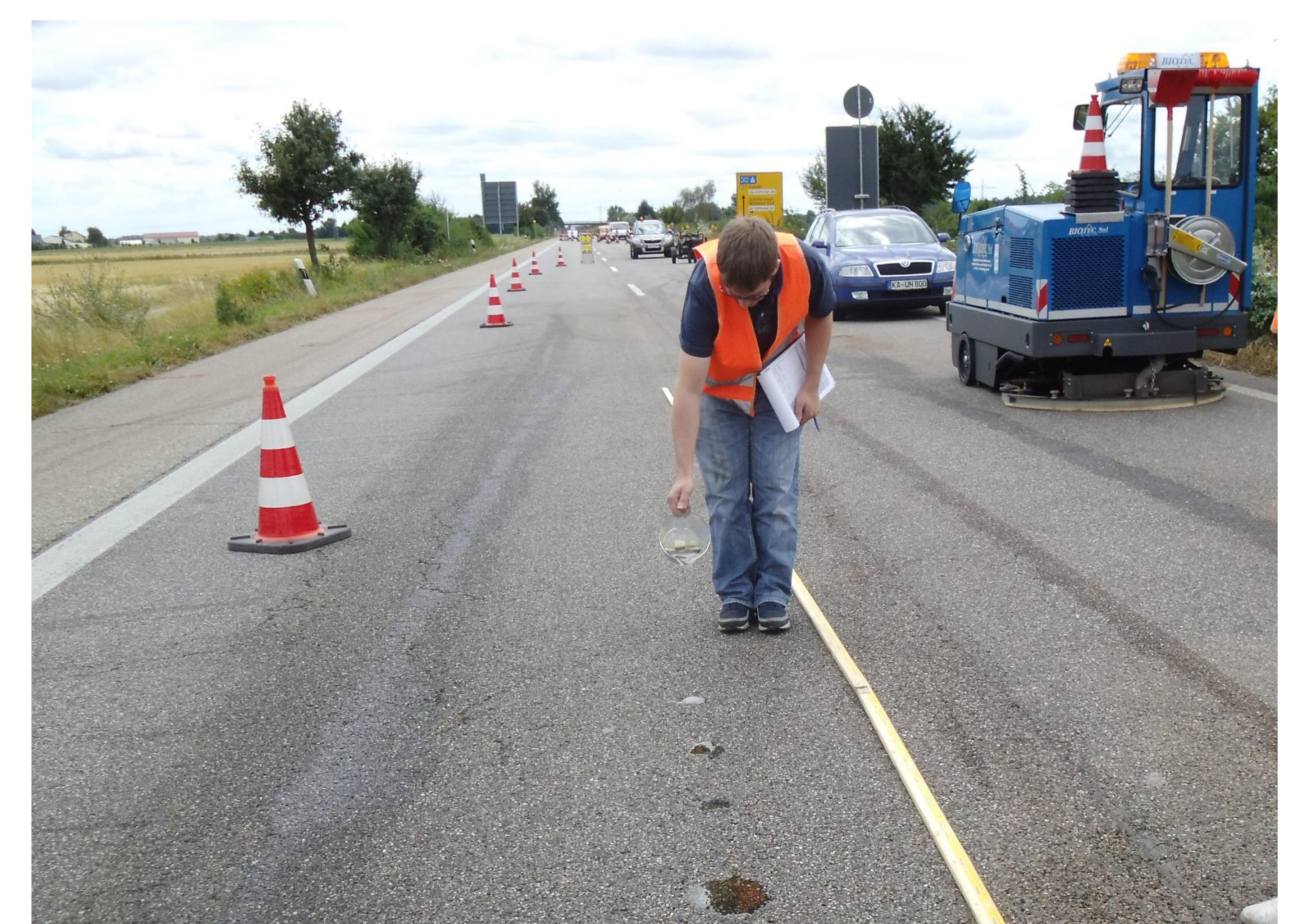
Aufbringen einer Tropfspur
